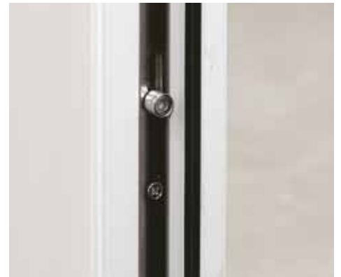
5 ponton záródó kilincsműködtetésű zárszerkezet
